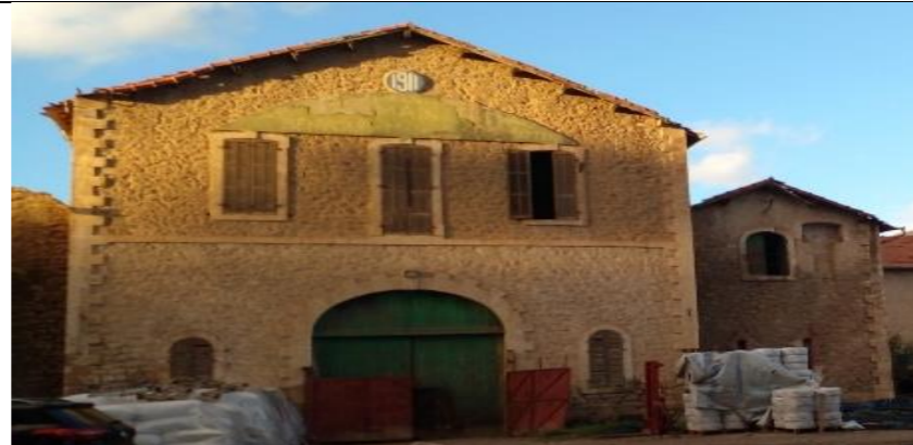
Maison double fonction avec cuve pour stocker le vin
