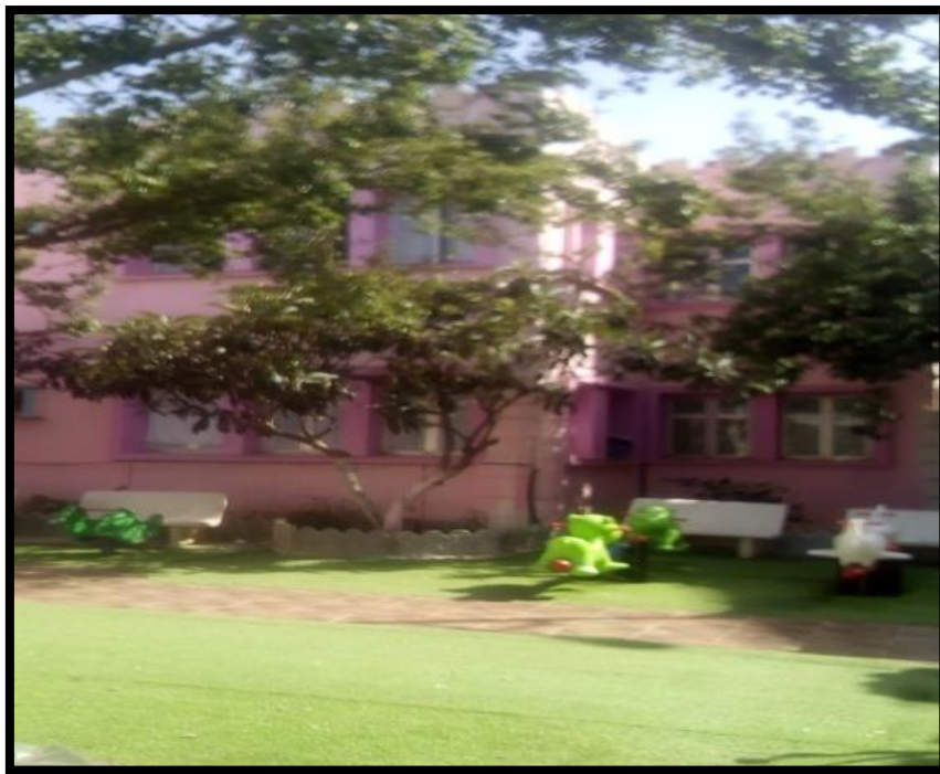
Figure 3.9 : photo prise de l'extérieur de la crèche montre les masques solaire (source : auteur, 2021)
