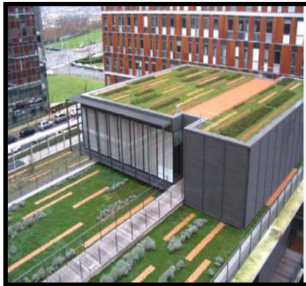
Figure 2.1 : exemple des toitures végétalisées (Djedjig, 2015)
