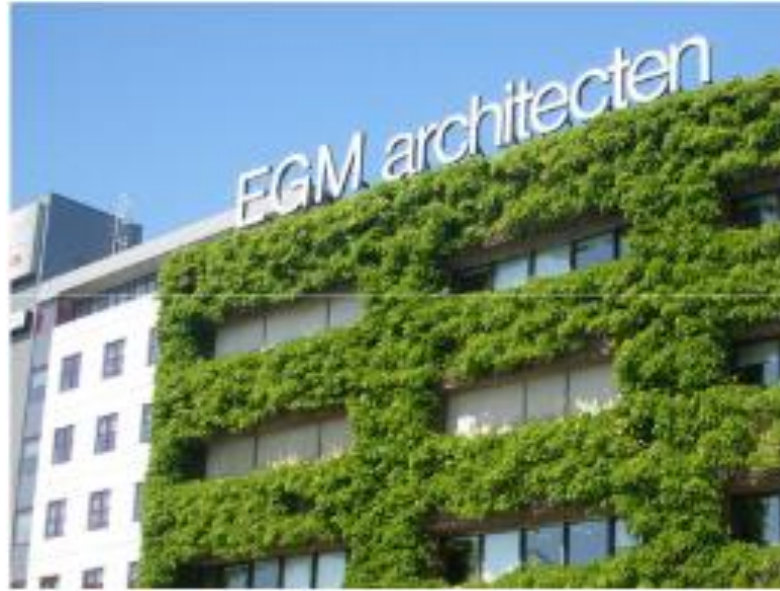
Figure 2.8 : bâtiment avec une façade végétalisée verte indirecte (source : Ottelé et all, 2011)
