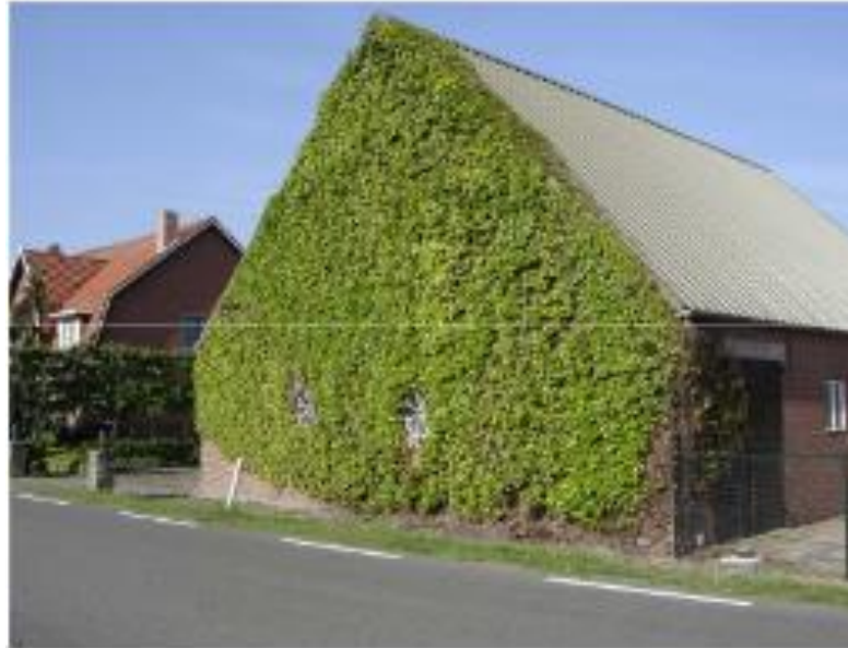
Figure 2.6 : bâtiment avec une façade végétalisée verte directe (source : Ottelé et all, 2011)
