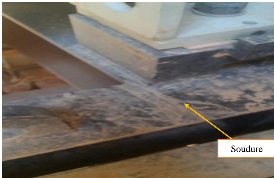
Figure I 9 fissure d'un châssis après soudure
