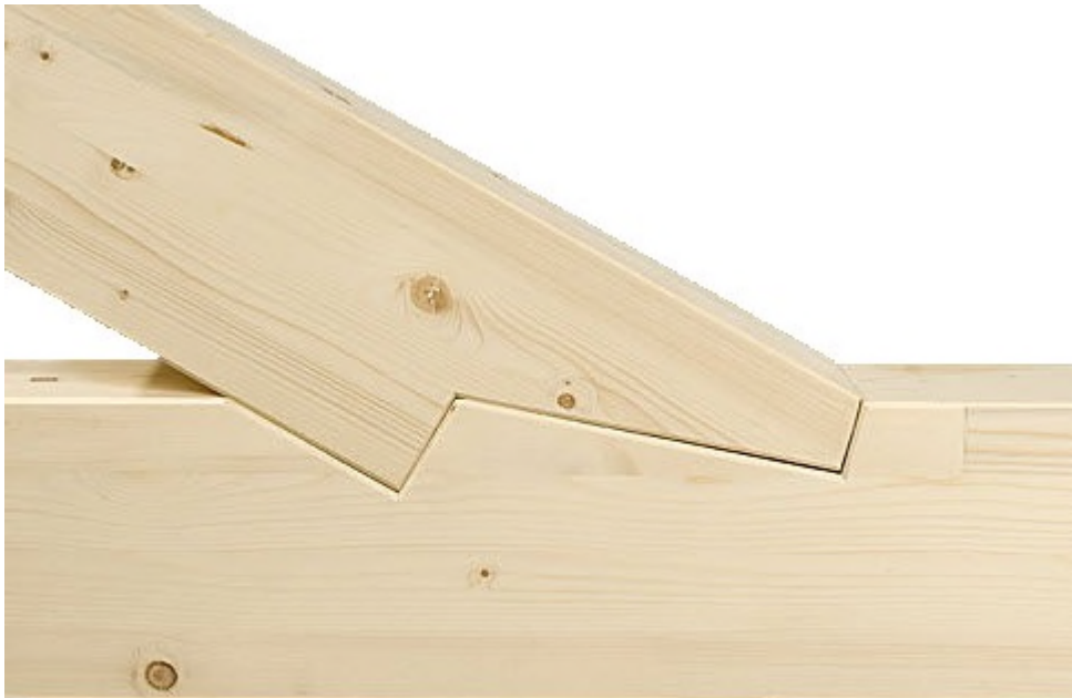
Figure 7 : assemblage par obstacle
