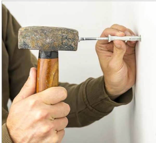
Figure 4 : assemblage avec cheville
