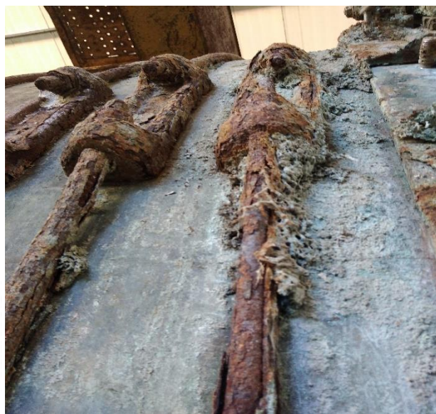
Figure I.2 : Une citerne corrodée
