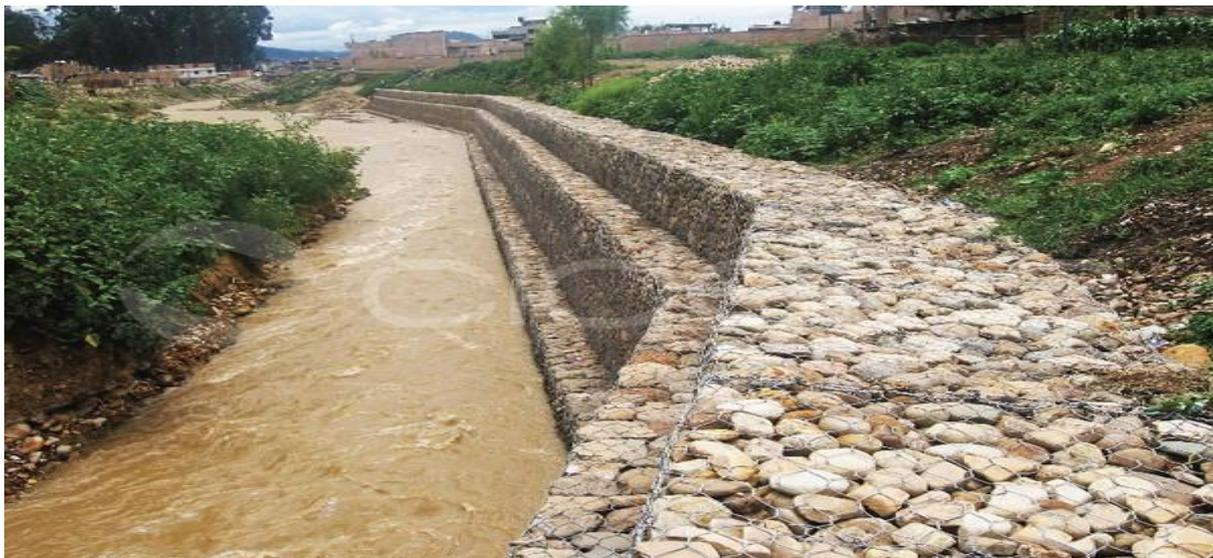
**Figure (IV.1) :** Canal aménagé avec un mur de soutènement en gabionnage.
