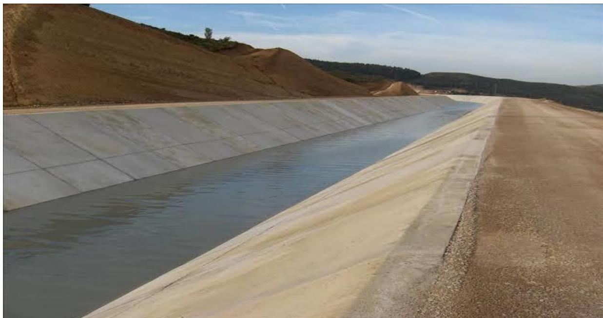
**Figure (IV.2) :** Canal en béton armé.
