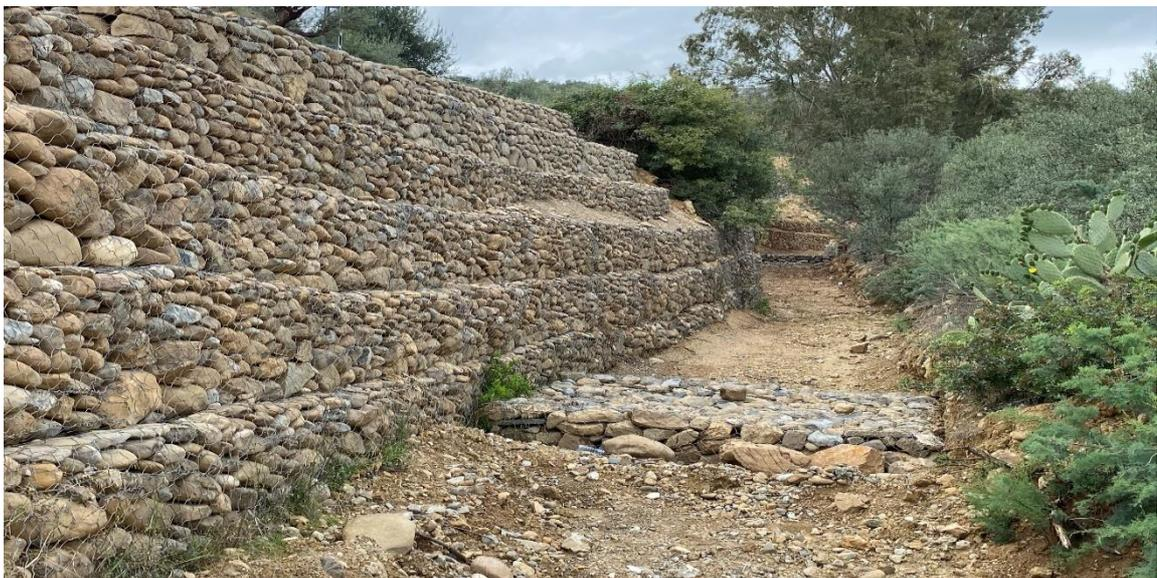
**Figure (III.1) :** Mur de soutènement a l'amont d'Oued KERMOUS.
