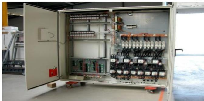
**Figure I-11:** Armoire électrique.
