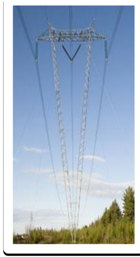
b) Pylône haubané en V
