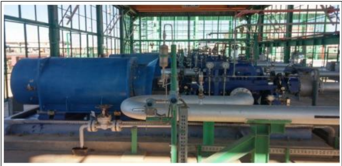
Figure 3.3 - Les électropompes principale GEP (A, B, C, D, E).
