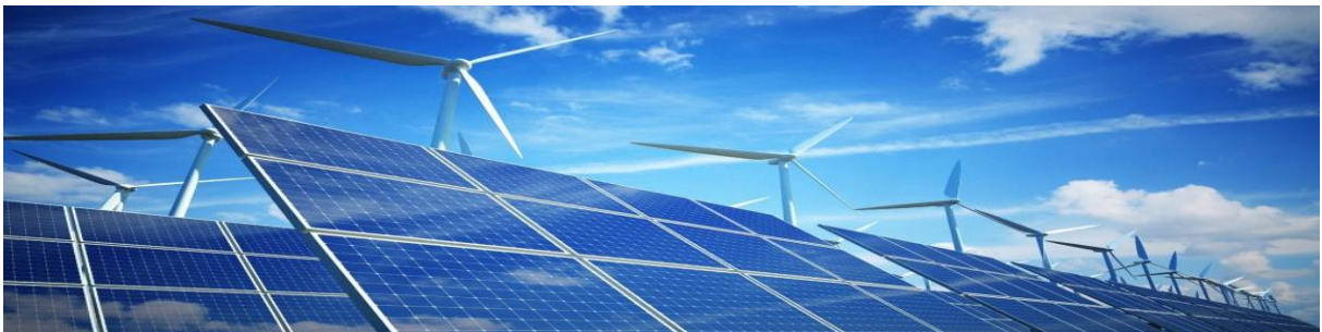
Figure I.26 : Système hybride (photovoltaïque-éolienne) [20]
