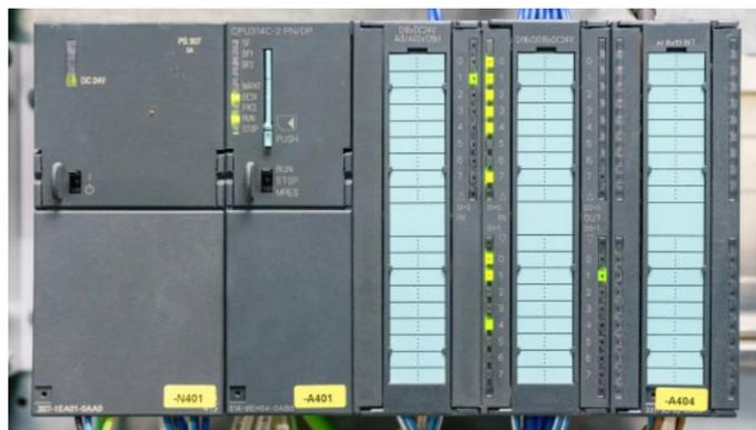
*Figure III.2 : Vue de l'automate S7-314C-2 PN/DP*
