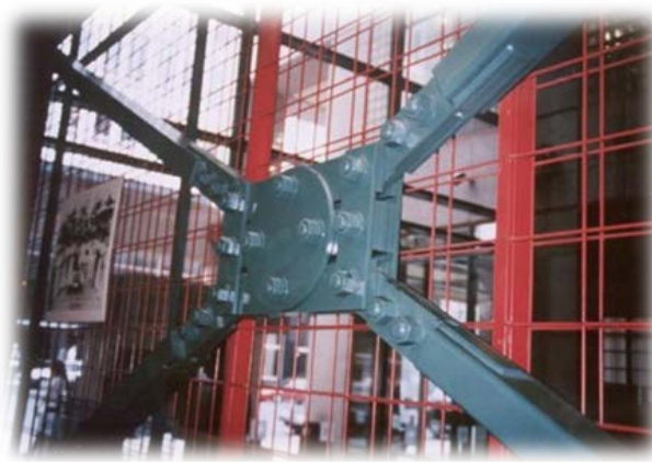
Figure 4 : exemple d'amortisseur à frottement
