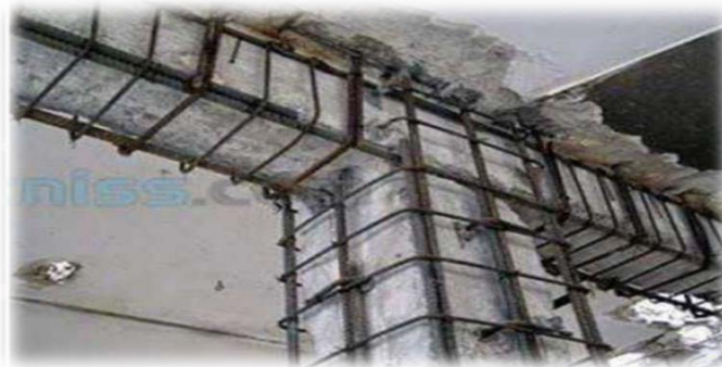
Figure 19 : Renforcement des poutres en acier
