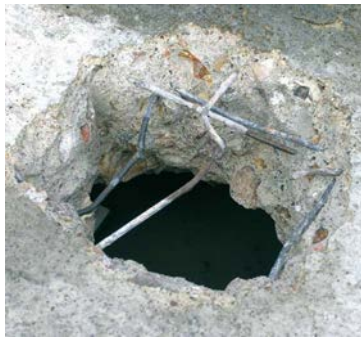
Figure 28 : trous réalisés par perforateur
