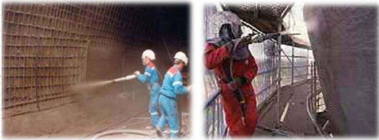
Figure 25 : Renforcement au moyen de béton projeté
