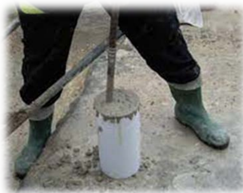
Figure 6 : Prélèvement sur le chantier
