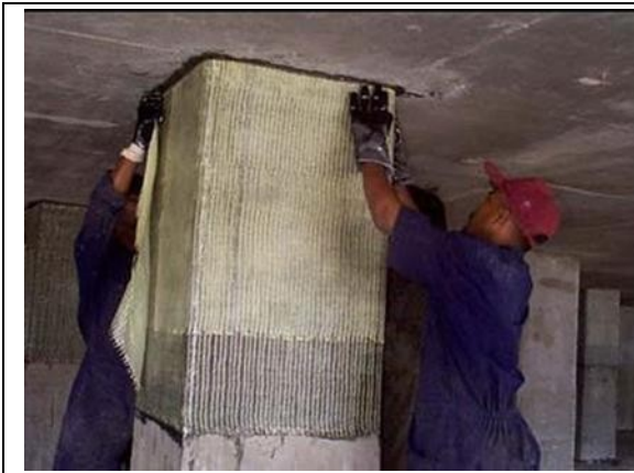
Figure 31 : Renforcement d'un poteau
