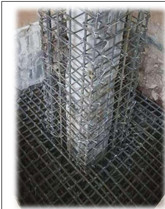
Figure 23: Renforcement par l'introduction de nouvelles fondations
