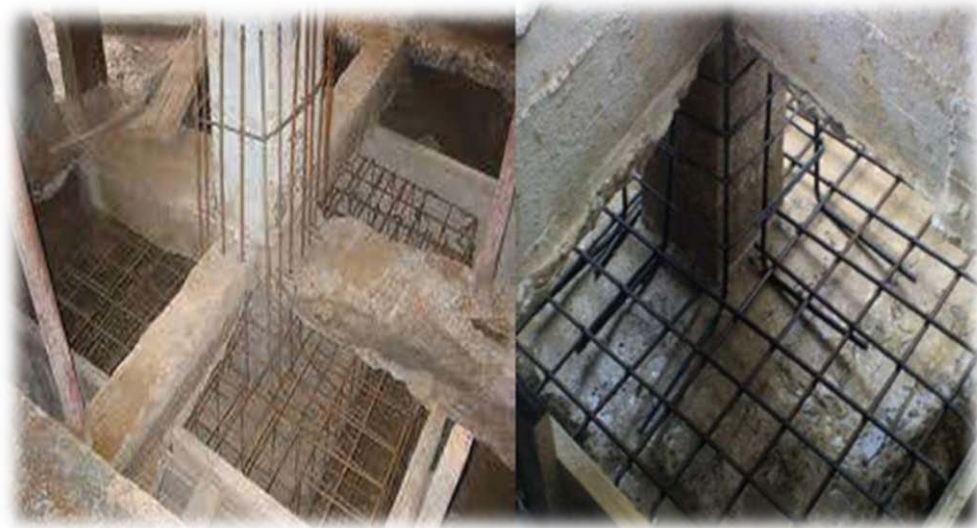
Figure 22 : Renforcement de fondations existantes
