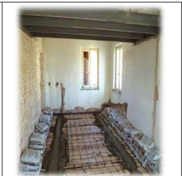
Figure 21 : Renforcement de plancher en béton armée
