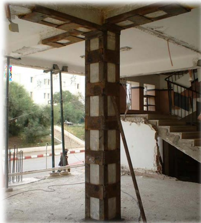
Figure 10 : Renforcement de poteaux au moyen de profils métallique
