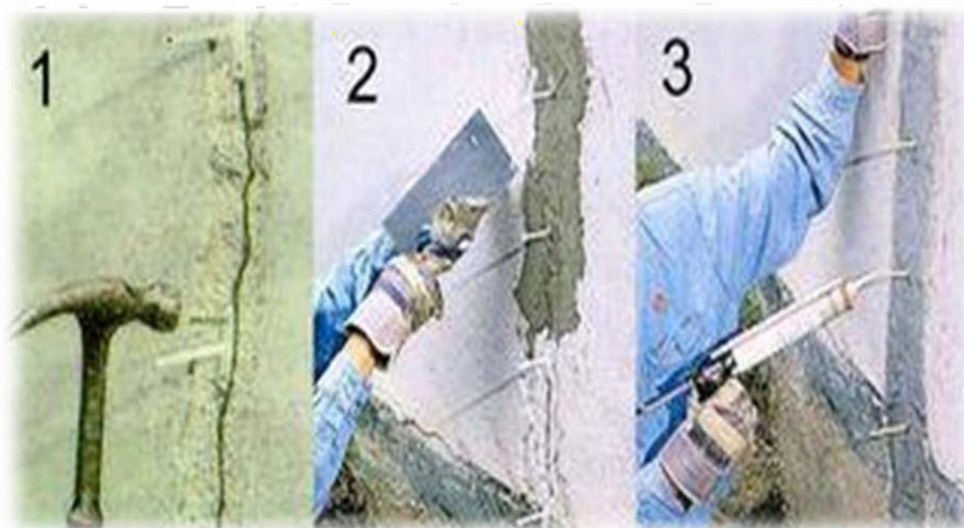
Figure 9 : La réparation d'une fissure à l'aide d'une injection
