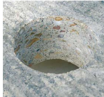
Figure 29 : trous réalisés par carotteuse.
