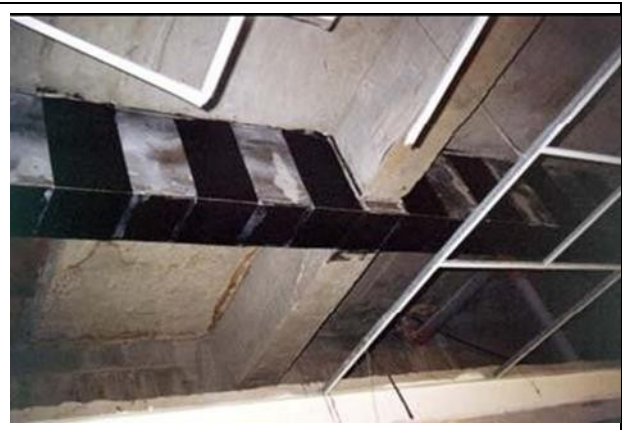
Figure 32 : Renforcement d'une poutre
