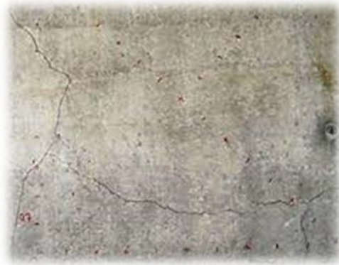
Figure 3 : Attaque par les sulfates
