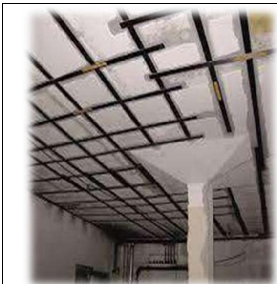
Figure 20 : Renforcement de plancher de profiles métallique
