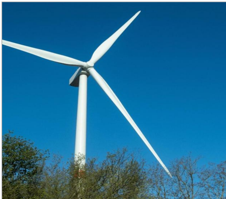
Figure I. 2: Eolienne axe horizontal.
