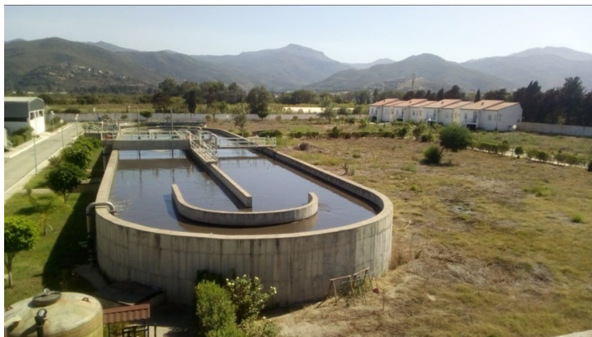
Figure II.5: Réacteur biologique (système Carrousel)
