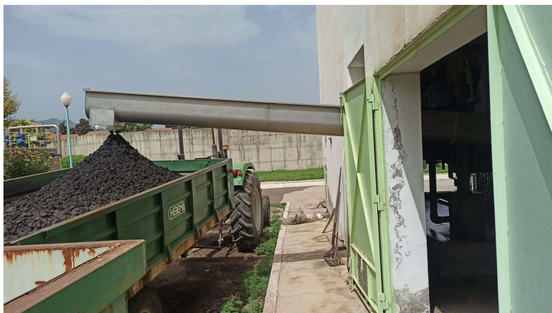
Figure II.9: Transport de boue déshydratée
