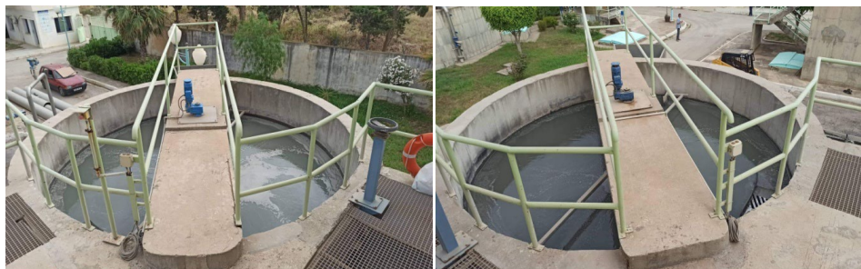
Figure II.4: Séparation du sable et de la graisse.
