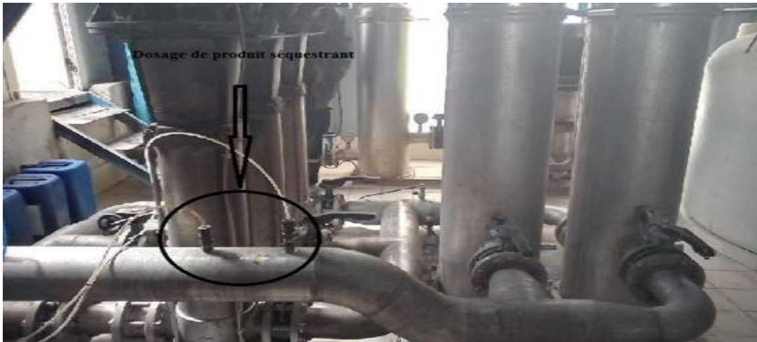
Figure I-4 : Photographie du dosage de produit séquestrant avant les filtres à cartouche [19]
