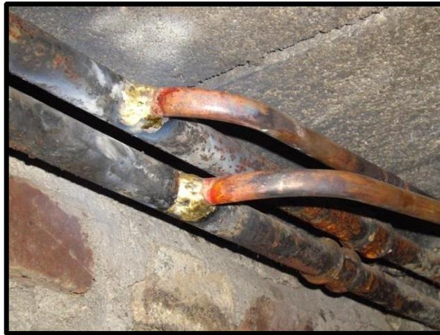
Figure I.2 : Corrosion chimique: cuivre et acier noir dans une installation [8].
