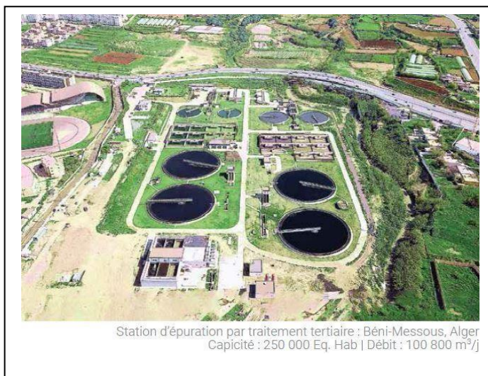
FIGURE N°04: station d'épuration par traitement tertiaire.
