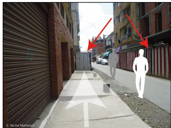
Figure 60 : Trottoir coupé par un obstacle au quartier de Lekhmis.
