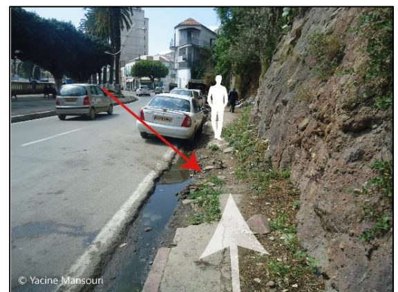
Figure 44 : Trottoir au quartier de Lekhmis.
