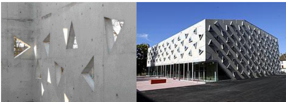
Figure I : Carapace en béton autoplaçant.
