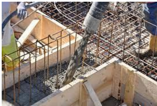
Figure I.6 : La mise en place du béton auto-plaçant
