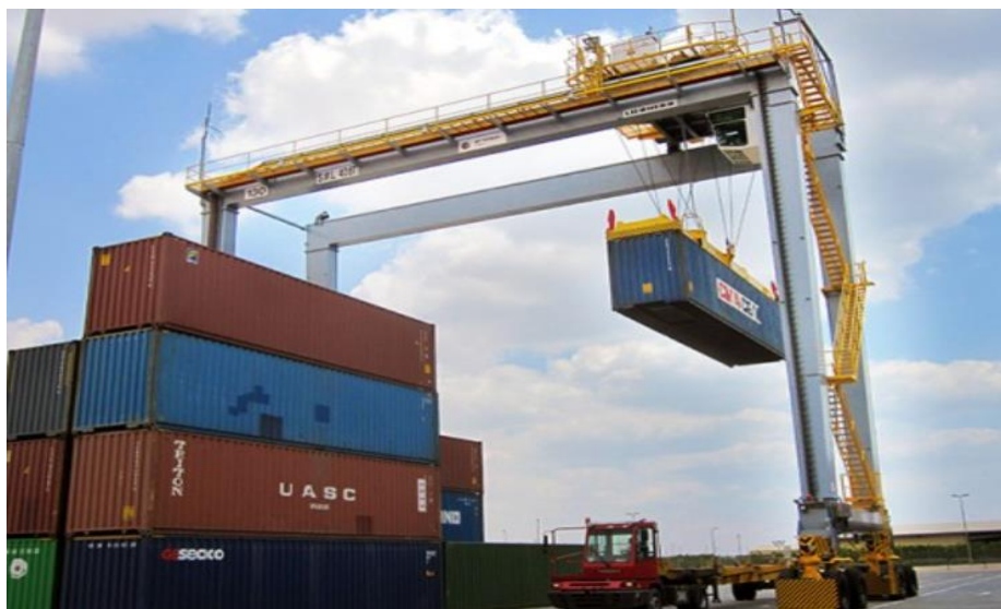
Figure I.5: Grue portique mobile sur pneus (RTG)
