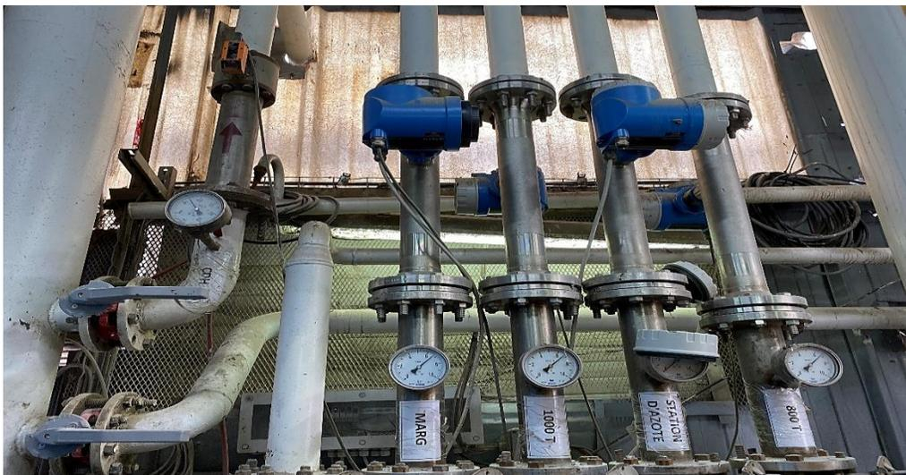
Figure I-3 : Unité de distribution de l’air comprimé vers les différentes stations.
