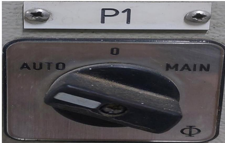
Figure II-3 : Commutateur de mode de fonctionnement de moteur.
