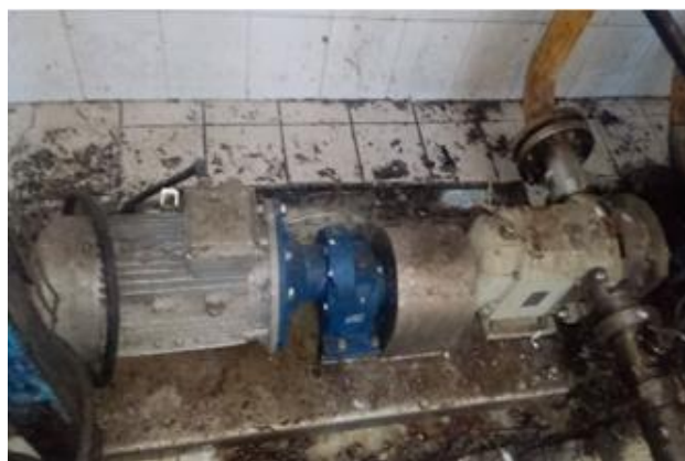
Figure I.12 : Pompe (Photo prise en entreprise).
