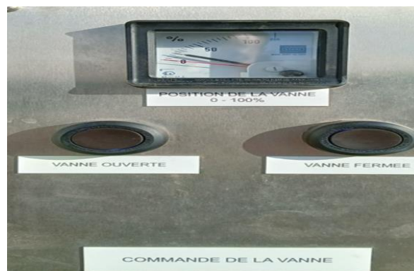
Figure I.23 : Commande de la vanne par le bouton poussoir.
