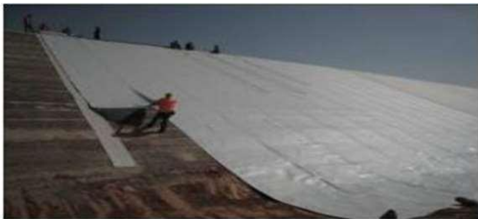
Figure I-8: Pose de géo membrane (Barrage de Sar Cheshmeh, Iran).
