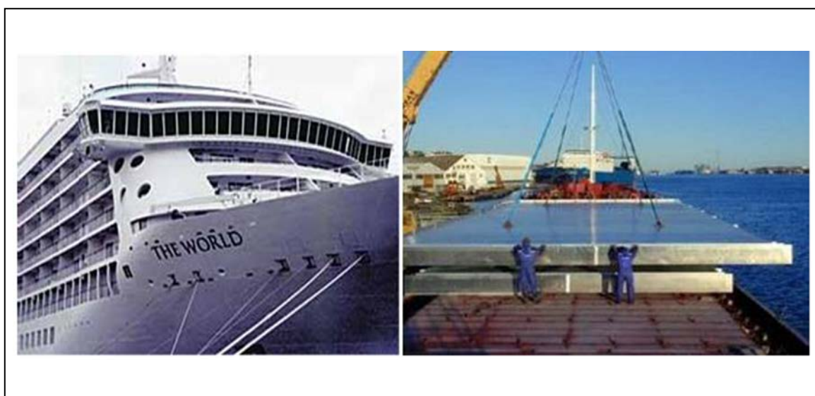
Figure 1.16 : (a) Bateau en aluminium construit en utilisant FSW / (b)-Panneaux préfabriqués (Hydro Marine Aluminium) destinés au pont du bateau de croisière [26].
