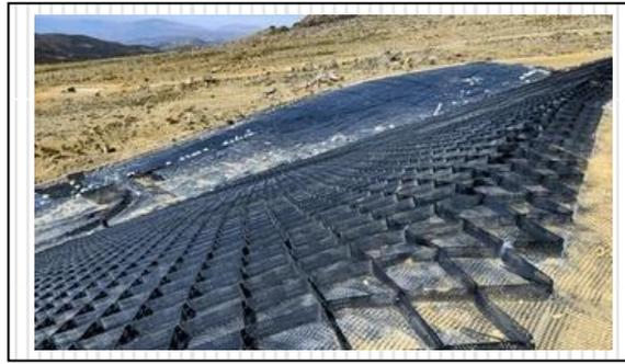
**Figure I. 1** : installation de géosynthétique [5].
