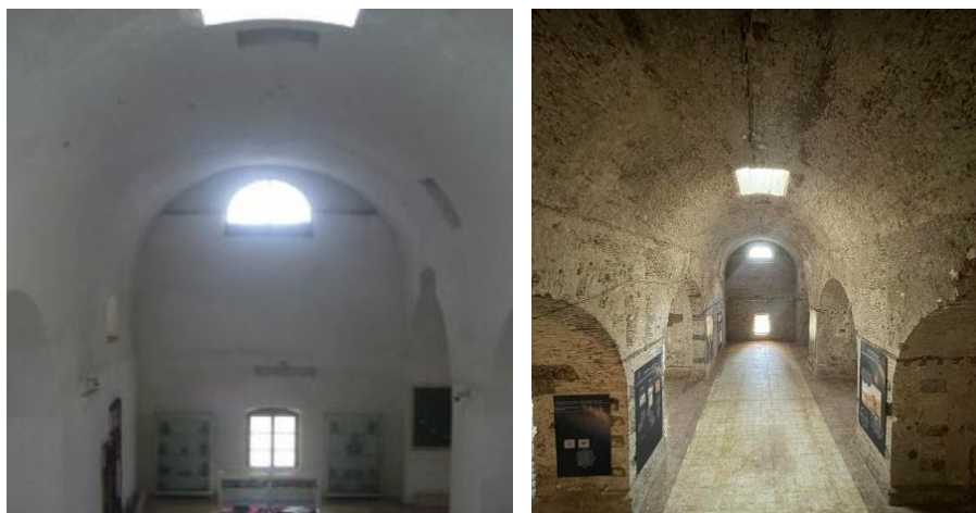
Figure 44 : Photo 1 : intérieur du fort Moussa après la restauration de 1987, source : Korichi Amina, 2008. Photo 2 : Intérieur du fort Moussa après les travaux de décapage et de crépissage, source : Auteure 2023
