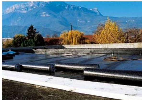
Figure 28: Isolation de la toiture. (Source : ADEME,2022)
