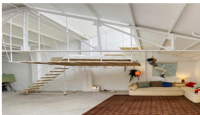
Figure 5: Mezzanine avec des poutres IPN. (Source : www.notreloft.com , 2023)
