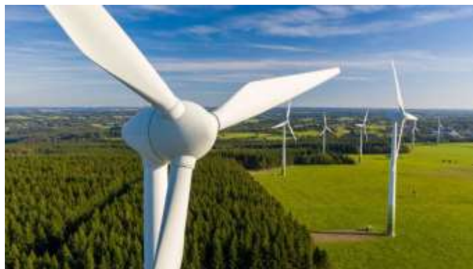
Figure I.2 : Eolienne à axe horizontal.
