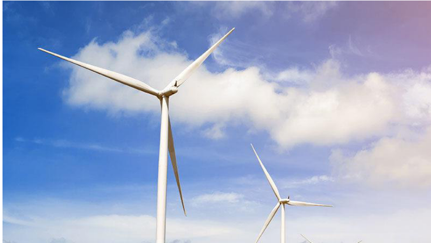
Figure I.9 : Eolienne a axe horizontale
