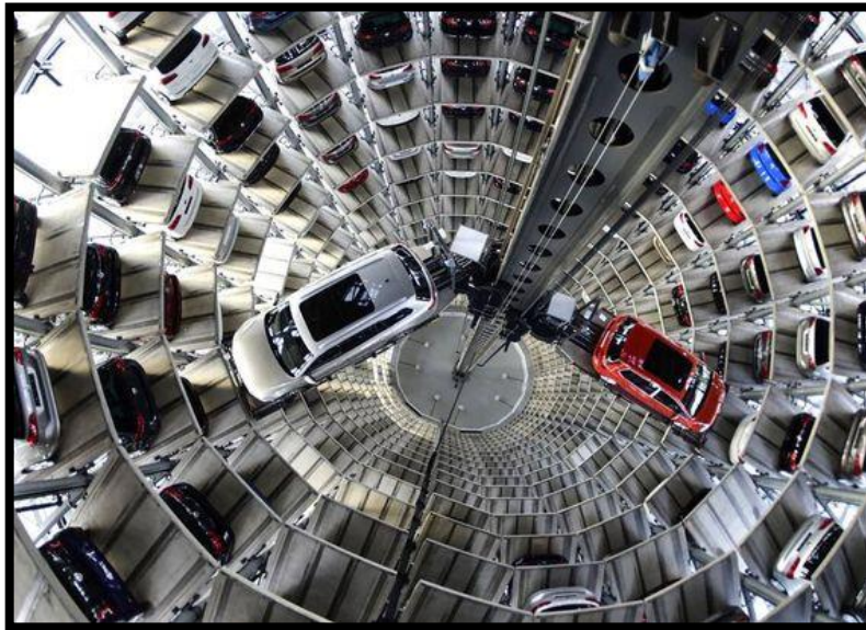
Figure (I.9) : Systèmes de stationnement en silo.
