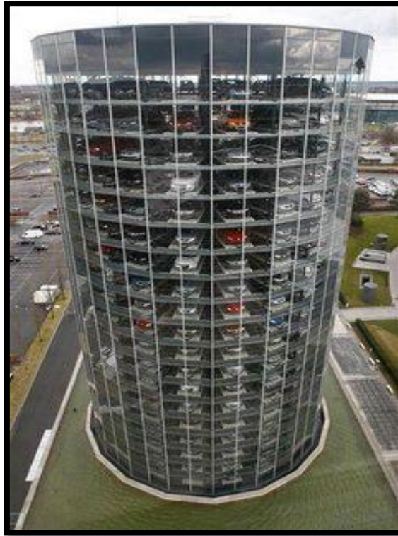
Figure (I.4): Parking automatisé dans une tour.
