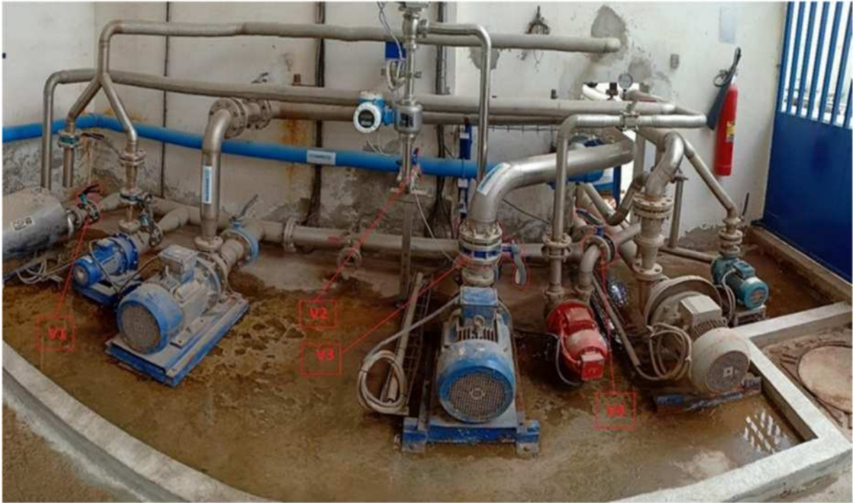
Figure (II.6) Photo des vannes manuelles V1, V2, V3 et V4
