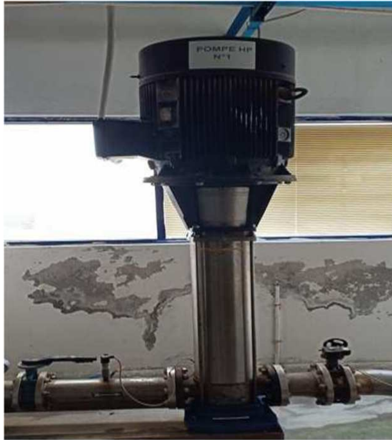
Figure (I.7) Photos de la pompe HP du 1er étage de l'osmoseur inverse.
