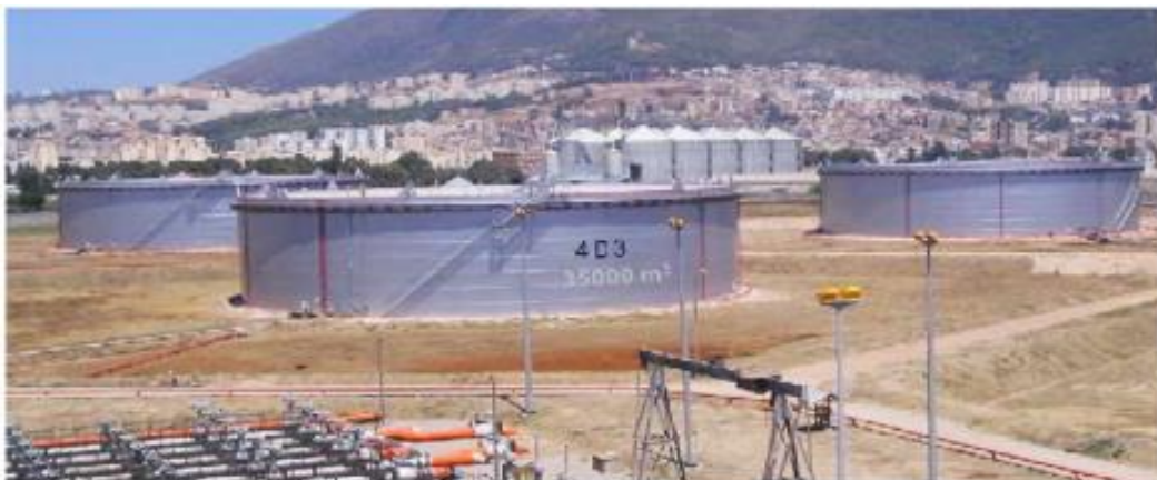
Figure I.3 : Bac de stockage du pétrole [8]
