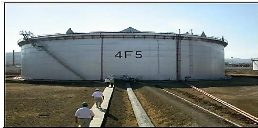
Figure I.8 : Bac de stockage a toit flottant [3]
