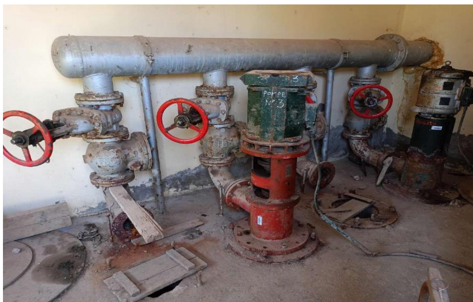
FigureIII.5: Pompe centrifuge raccorder avec moteur.
