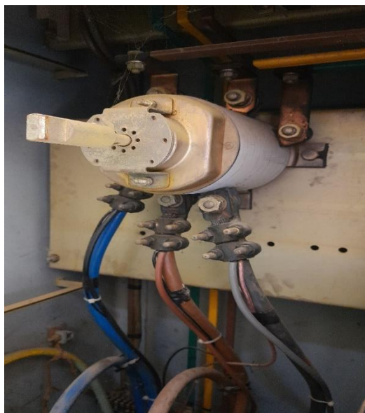
FigureIII.18: Sectionneur.
