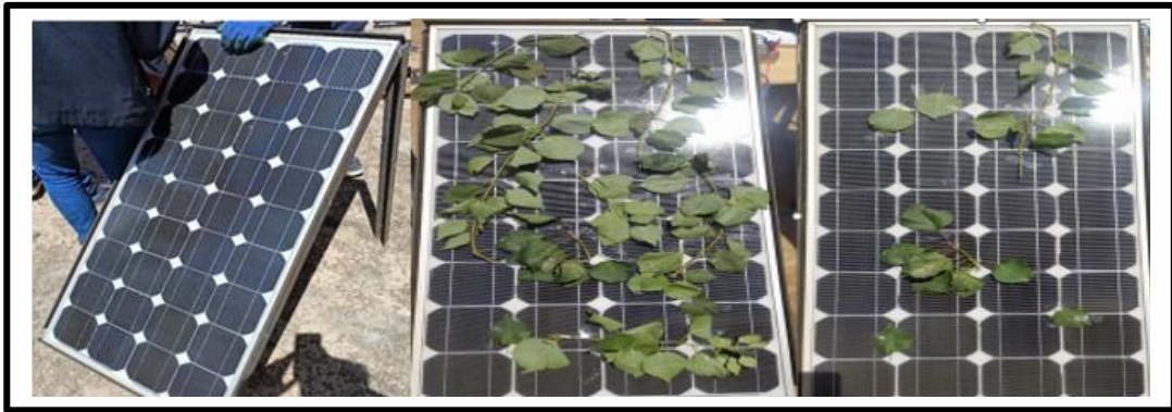
Figure III.15. Défaut de couverture par les feuilles d'arbre.
