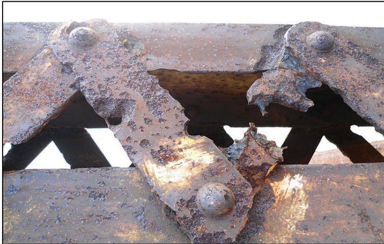
**Figure. I.2.** Rupture par corrosion
