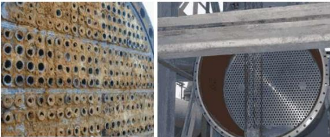
Figure1-5: Echangeur sale et propre
