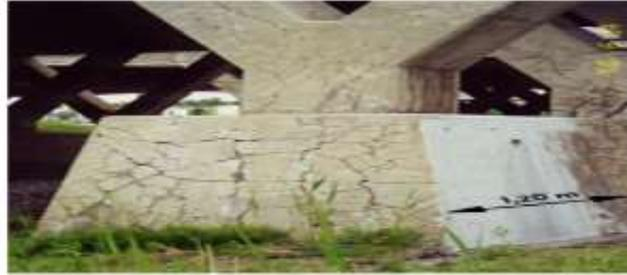
Figure I.7 : Dégradation par alcali-réaction
