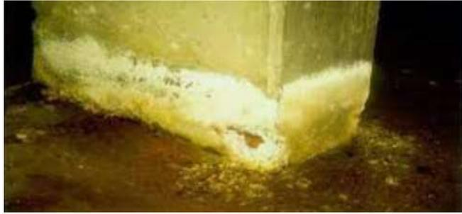
Figure I.8 : Dégradation par les attaques sulfatiques
