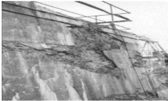
**Figure I.5 :** Phénomène causé par le cycle gel-dégel
