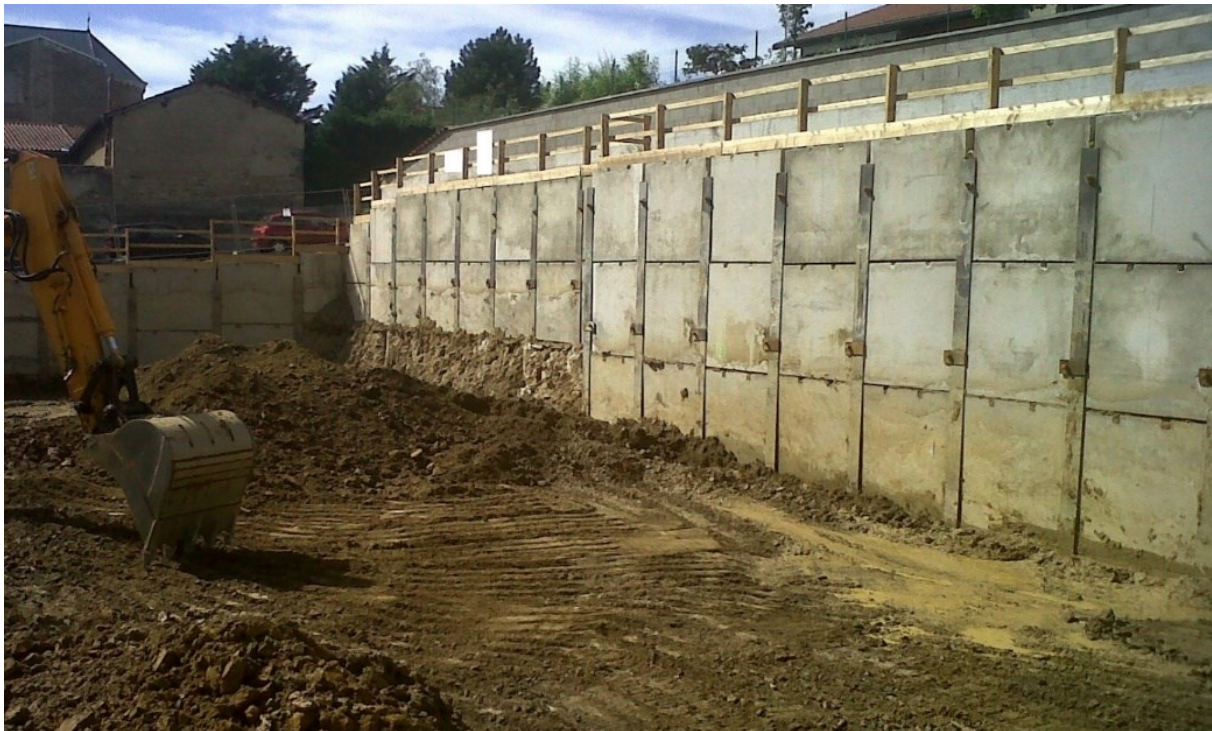
Figure II.17 Exemple d'une paroi berlinoise
