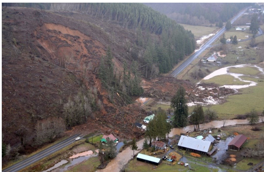
Figure IV.5 Exemple des coulées boueuses
