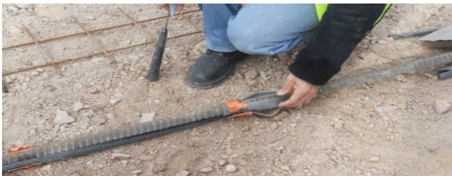
Figure II.11 Clou métallique avec Centreur
