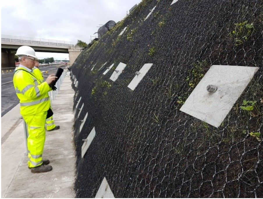
Figure II.6 Exemple de Clouage de Sol
