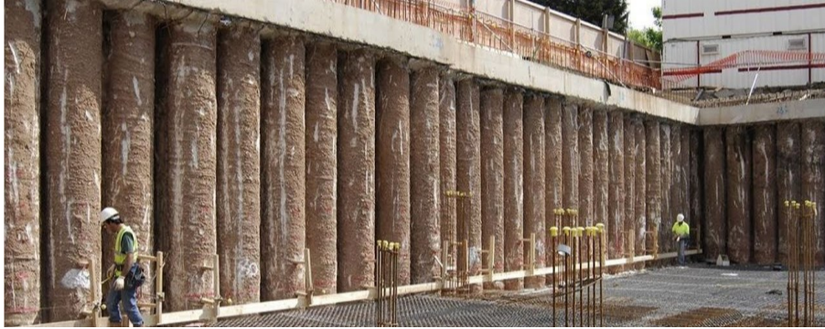
Figure II.13 Pieux Profond Pour Soutènements
