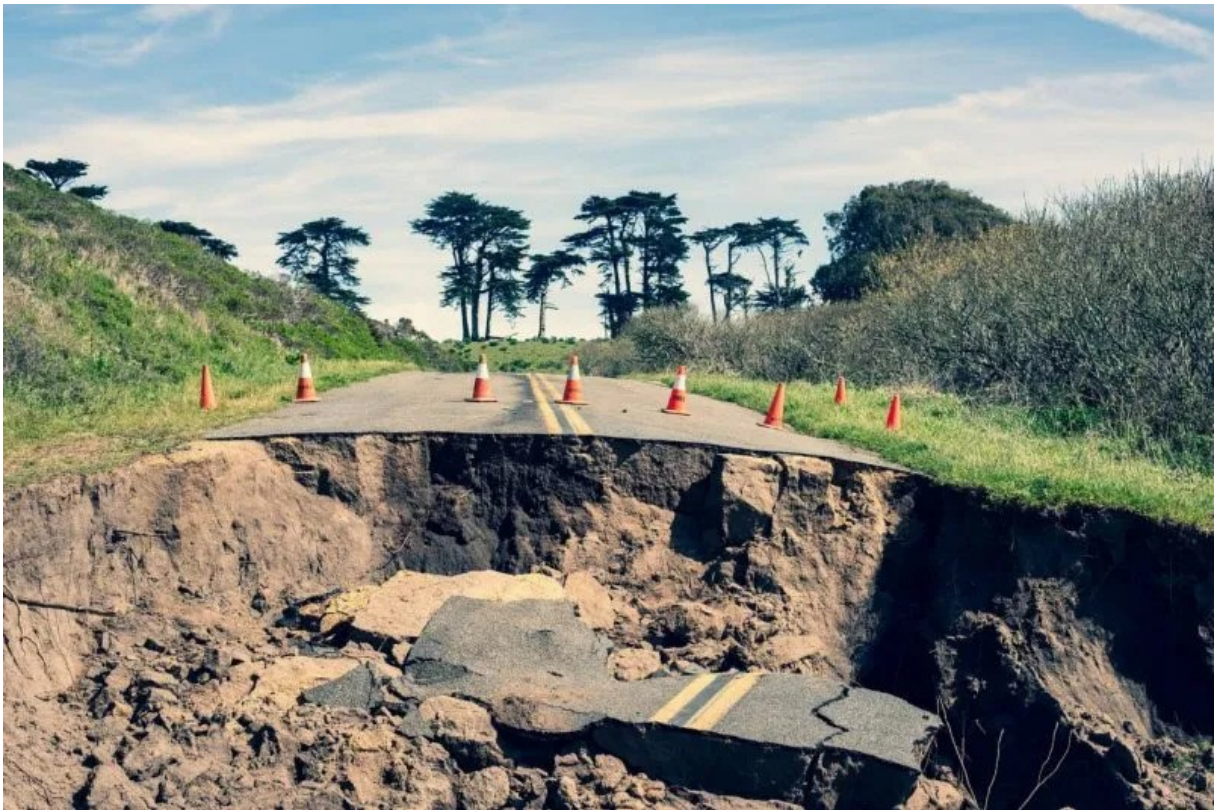
Figure I.6 Exemple d'affaissement de sol
