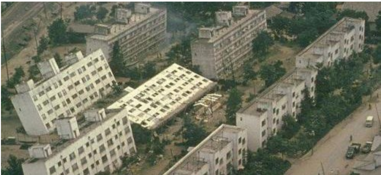
Figure I.8 Liquéfaction du sol : Cas de Niigata, JAPON.
