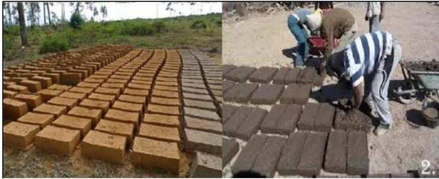
Figure 1. 14 : Moulage et séchage des blocs adobes
