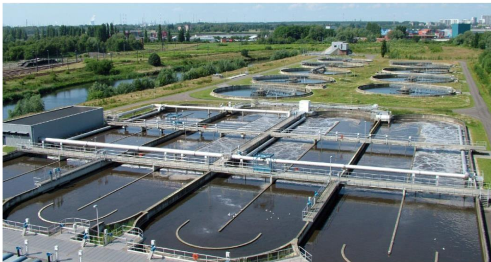
Figure 4 : Station d'épuration des eaux usées (Photographie 2)
