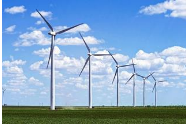
Figure (I.2) : Aérogénérateurs à axe horizontal
