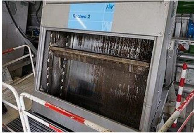
**Figure 3.** Dégrilleur en entrée de station d'épuration (ANSES, 2015)
