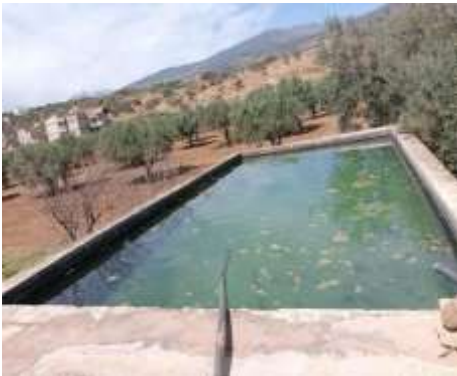
Bassins d'eau à Tazmalt
