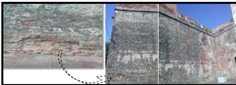
Figure 3.33: vue sur la façade Est (Appareillage français), Source : auteurs 2016
