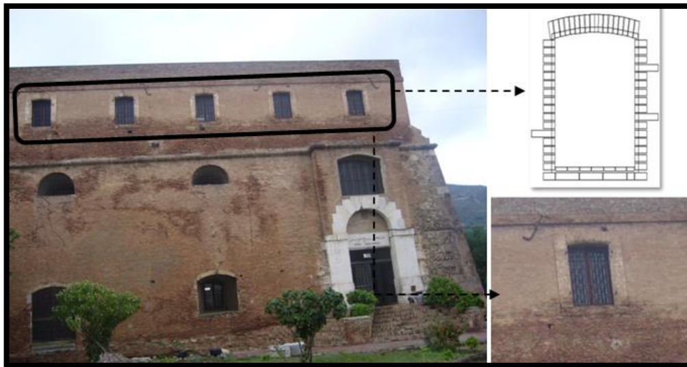
Figure 3.69: la façade sud, Source : auteurs 2016
