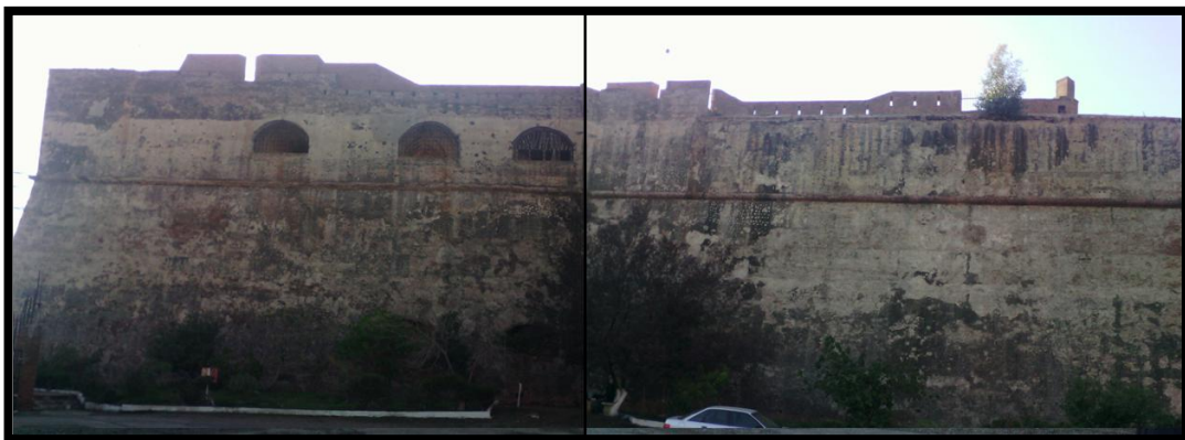
Figure 3.27: vue sur la façade nord, Source : auteurs le 05/12/2016
