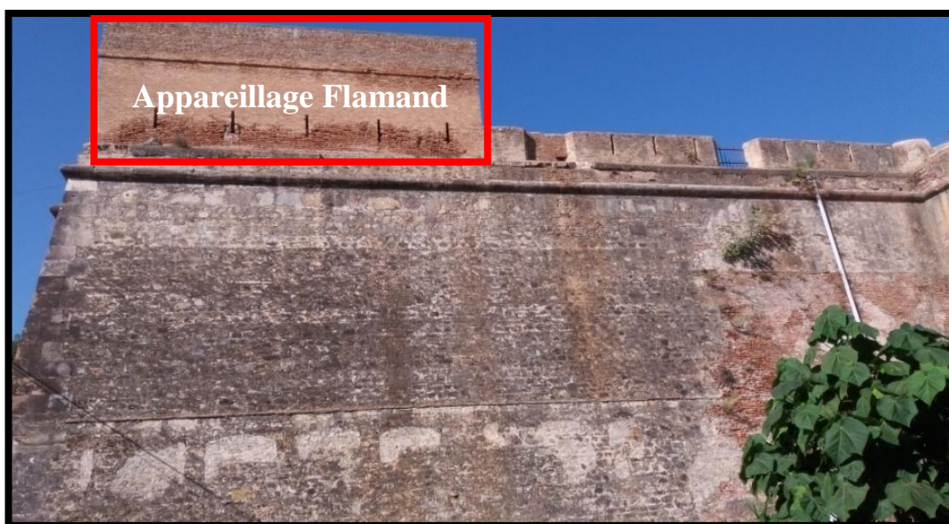
Figure 3.78: les appareillages sur la façade est, Source : auteurs 2016
