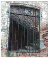
Figure3.90 : fenêtre en arc surbaissé Source : Auteurs le 05/12/2016
