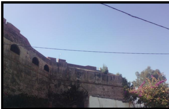
Figure3.9 : vue sur la façade nord de BORDJ MOUSSA Source : Auteurs le 05/12/2016
