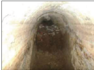
Figure 3.41 : Vue sur le tunnel Source : BET MAHINDAD
