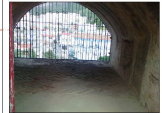
Figure3.92 : Appareillage en arête de poisson Source : Auteurs le 05/12/2016
