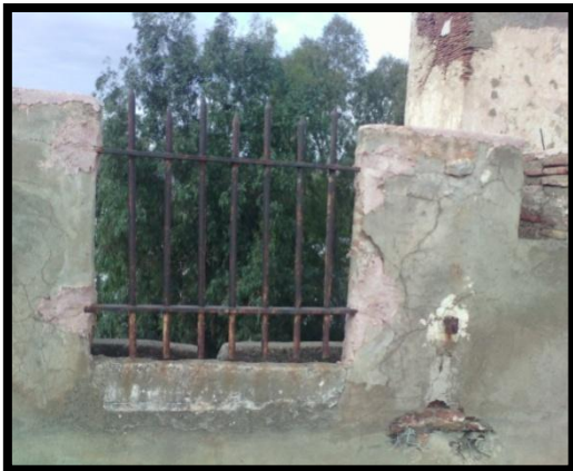
Figure 3.80: Embrasure fermé avec une grille métallique Source : auteurs 05/12/2016
