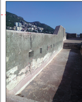
Figure3.101: vue sur les meurtrières du cavalier Source : Auteurs le 05/12/2016
