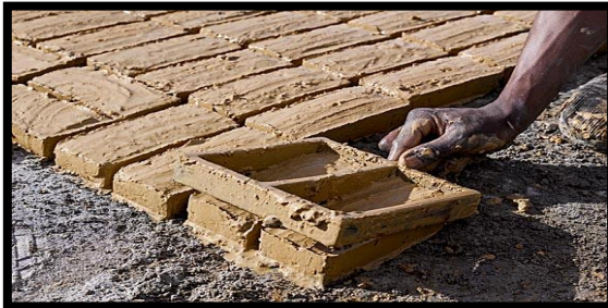
Figure2.8 : le moulage de la brique Source : ADOBES-BTC-BRIQUE-TERRE-CUIITE-LE-GABION-un-webreportage-www.autoconstruction.at
