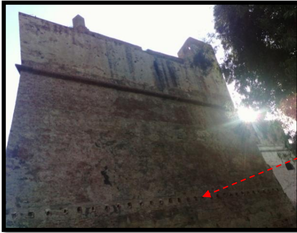
Figure 3.61: vue sur le bastion ouest de fort BARRAL Source : Auteurs le 05/12/2016
