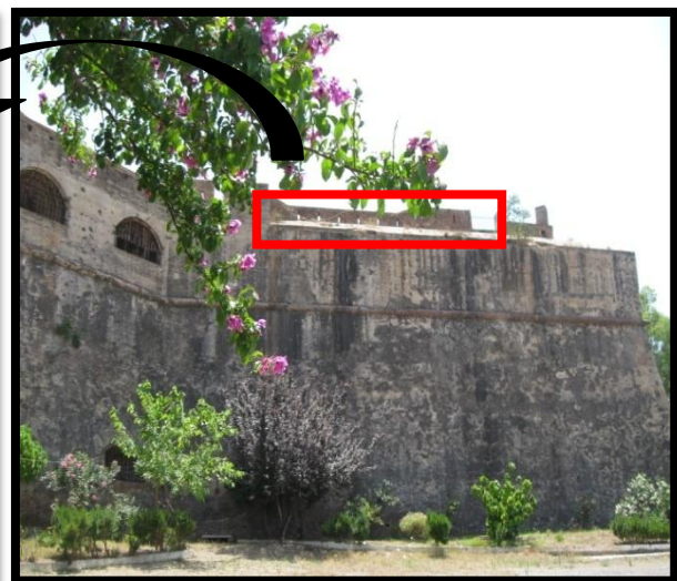
Figure 3.75: Meurtrières sur la façade nord Source : auteurs 05/12/2016
