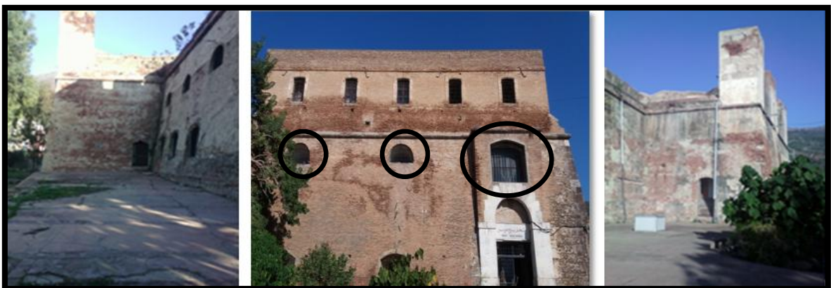
Figure 3.68: la façade sud, Source : auteurs 2016
