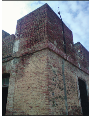
Figure3.98: vue sur la cage d'escalier Source : Auteurs le 05/12/2016
