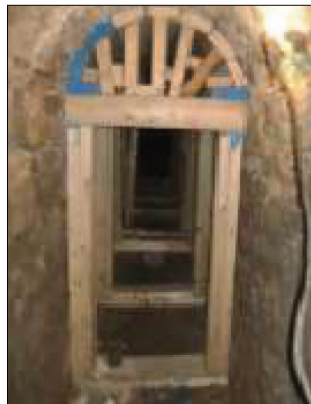
Figure 3.42 : Vue sur le tunnel Source : BET MAHINDAD
