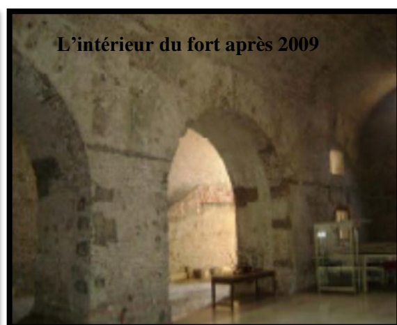
Figure 3.105: Vue sur l'intérieur de BORDJ MOUSSA après 2009 Source : BET MAHINDAD
