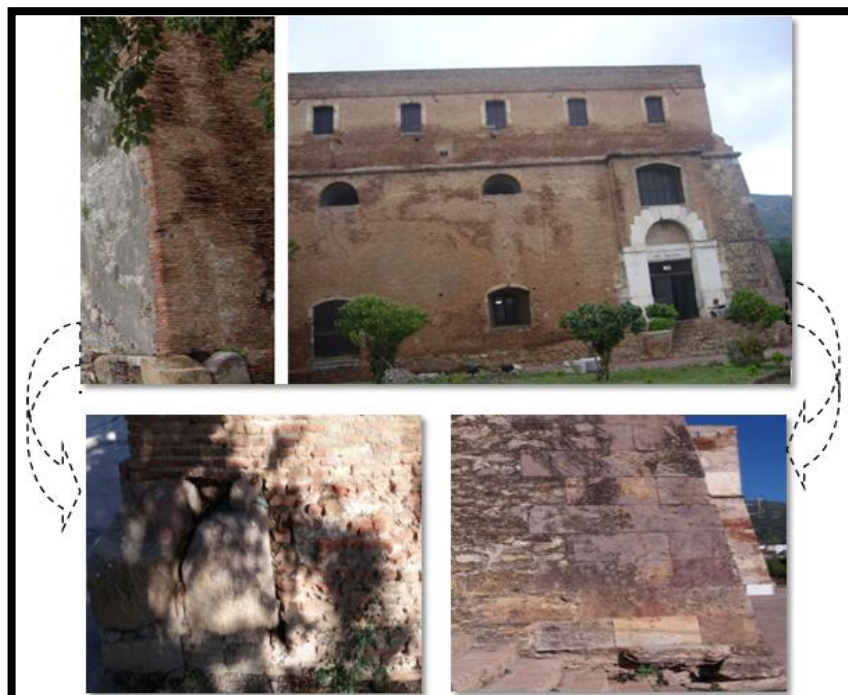
Figure 3.22: Utilisation de la pierre de taille sur la façade sud, Source : auteurs 2016
