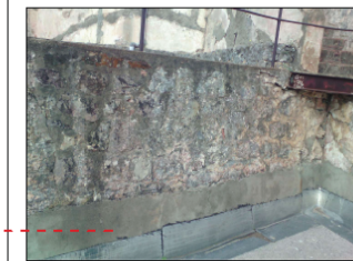
Figure3.57 : L'utilisation du métal Source : Auteurs le 05/12/2016
