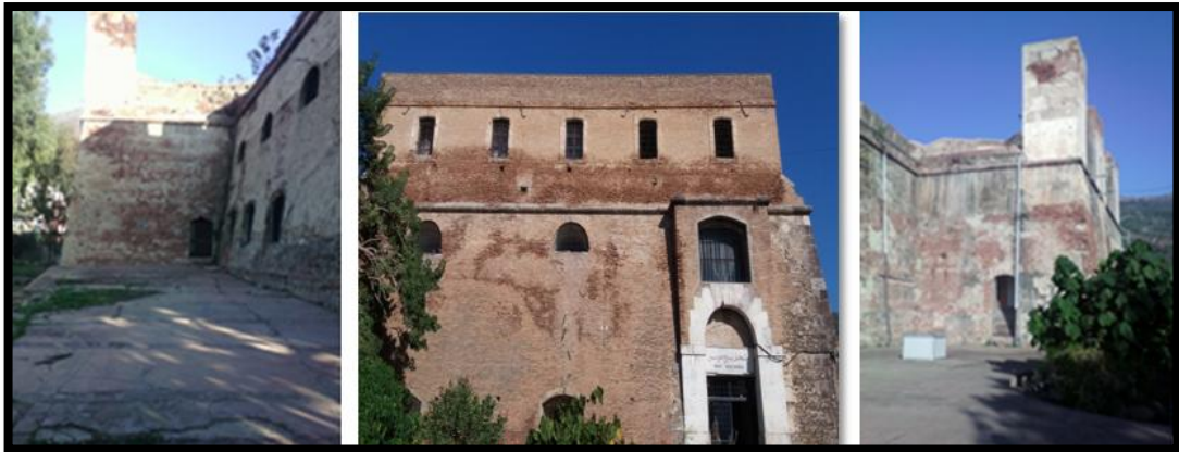
Figure 3.17: Vues sur la façade sud, Source : Auteurs le 05/12/2016
