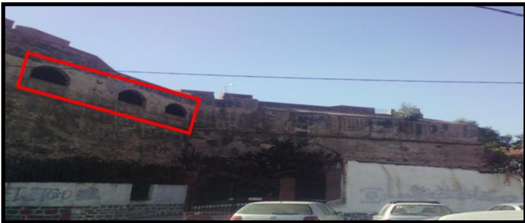
Figure 3.73: vue sur les ouvertures en forme d'arcs en plein cintre de la façade nord Source : auteurs 05/12/2016
