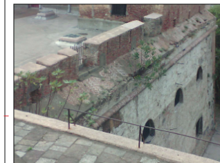
Figure3.55 : les embrasures, coté sud-ouest Source : Auteurs le 05/12/2016
