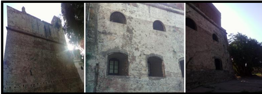
Figure 3.35: Vues sur la façade Ouest, Source : Auteurs le 05/12/2016
