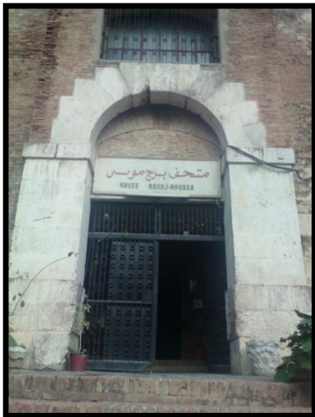
Figure 3.58: Vue sur la porte d'entrée de fort BARRAL Source : Auteurs le 05/12/2016
