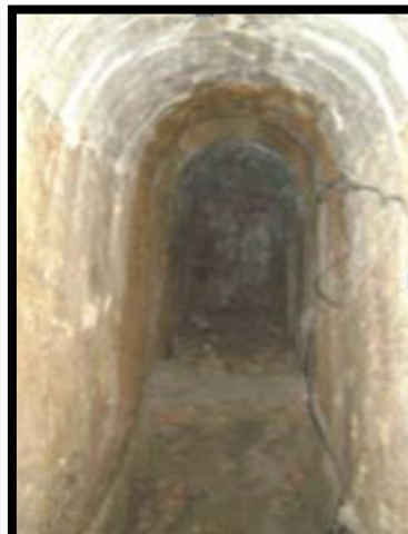
Figure 3.13 : vue sur le tunnel Source : BET MAHINDAD
