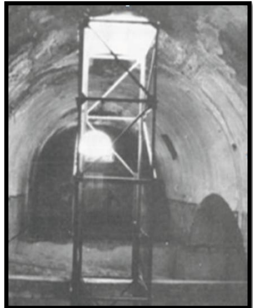
Figure 3.59: Vue sur le plancher intermédiaire et le monte charge Source : ROBERT HERRMANN
