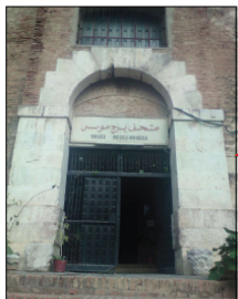
Figure3.85 : porte d'entrée Source : Auteurs le 05/12/2016
