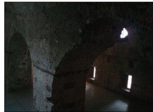
Figure 3.46 : Vue sur la grande salle Source : BET MAHINDAD
