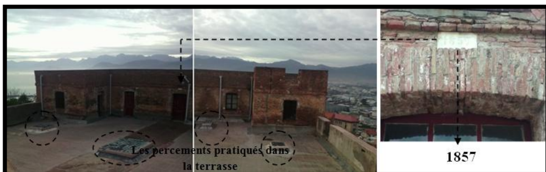
Figure 3.82: Vue sur le sud de la terrasse de BORDJ MOUSSA, Source : auteurs 2016
