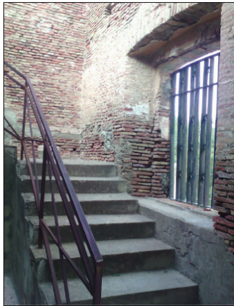
Figure3.96: Escalier qui mène au 2 ème étage Source : Auteurs le 05/12/2016
