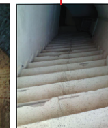
Figure 3.51 : Vue sur l'escalier Source : Auteurs le 05/12/2016
