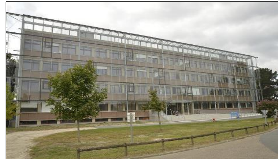
Figure 72 : Bâtiment A1 et sa façade bioclimatique. (Source : université de bordeaux, 2015.)
