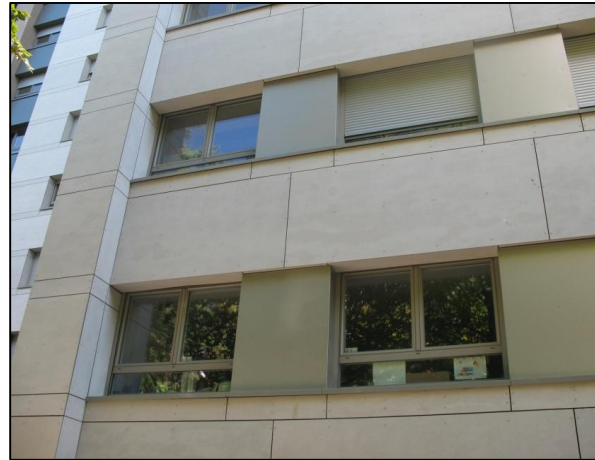
Figure 50 : Vue sur les fenêtres après réhabilitation énergétique. (Source : F. SGORBINI, 2013, p21.)
