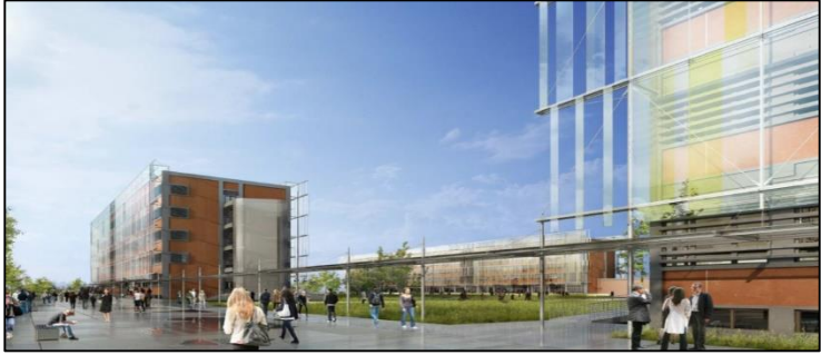
Figure 68 : université de bordeaux après réhabilitation énergétique. (Source : J.LOPEZ, B.CARRERE, 2015, p 36.)
