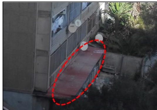
Figure 113 : La dalle coulée au niveau de l'entre-sol. (Source : auteurs, 2016.)
