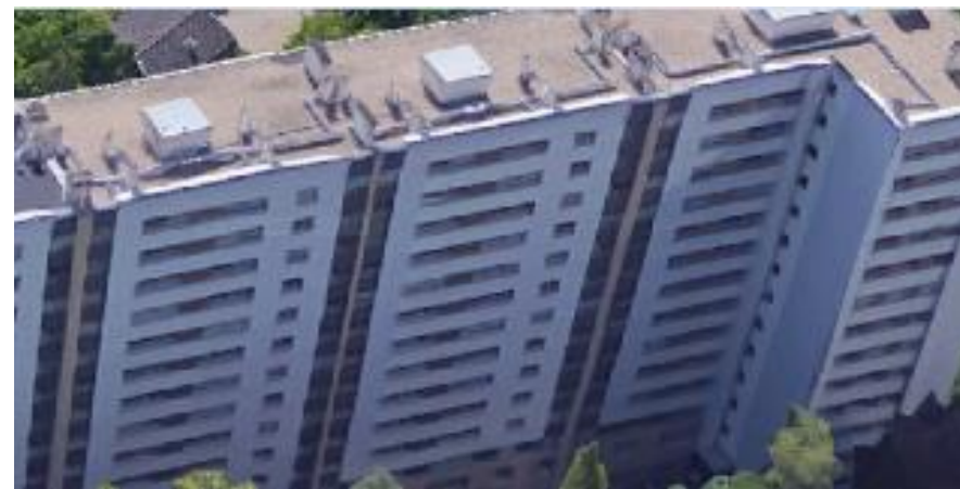
Figure 65 : Vue sur les souches maçonnées après réhabilitation énergétique. (Source : Google Earth, 2016.)
