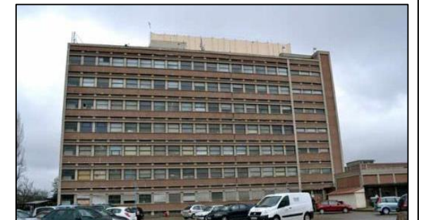
Figure 37 : l'un des bâtiments à réhabiliter. (Source : verre et protections, 2013.)
