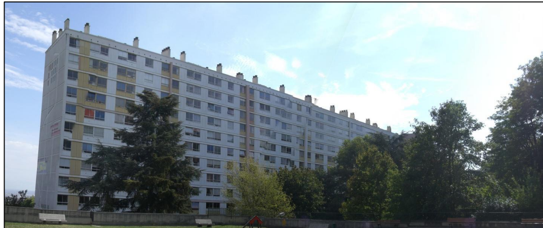
Figure 34 : Vue sur la façade Ouest depuis l'accès avant travaux de réhabilitation énergétique. (Source : F. SGORBINI, 2013, p 04.)
