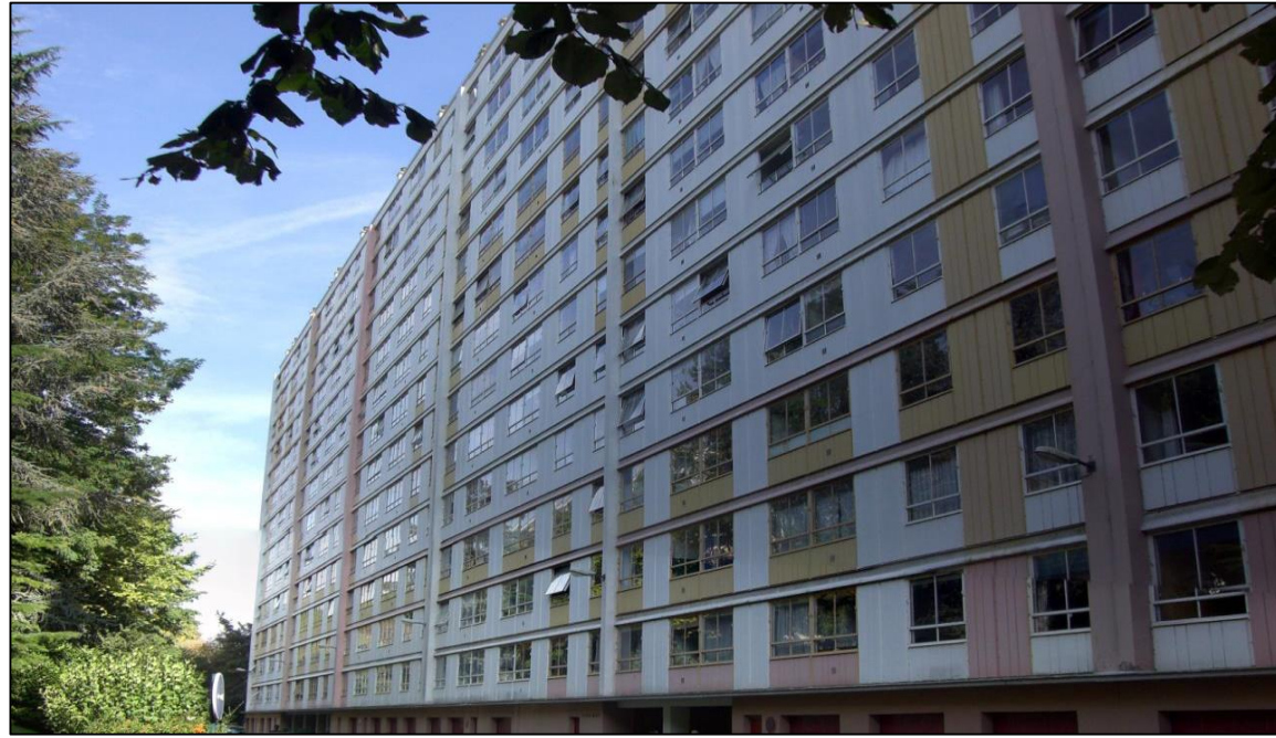
Figure 69 : Vue sur la façade Ouest avant réhabilitation énergétique. (source : F. SGORBINI, 2013, p 05.)
