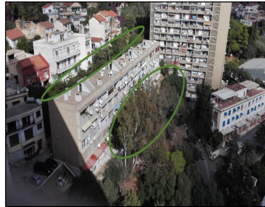
Figure 146 : Vue depuis l'immeuble 01 montrant l'obstacle. (Source : auteurs, 2016.)
