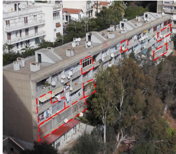
Figure 153 : Loggias de l'immeuble 3. (Source : auteurs, 2016.)
