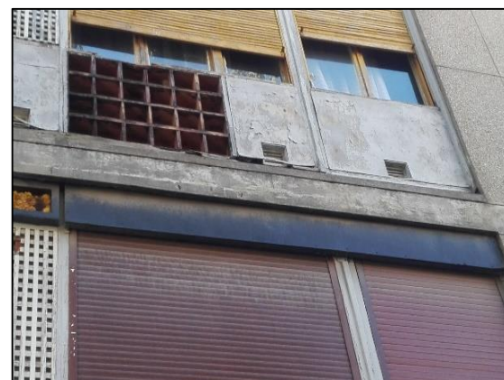
Figure 120 : Fenêtre en bois à simple vitrage. (Source : auteurs, 2016.)
