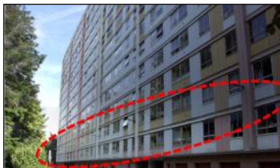
Figure 38 : Bandeau horizontal au-dessus du rez-de-chaussée. (Source : F. SGORBINI, 2013, p 24, traitée par les auteurs, 2016)
