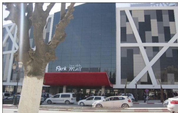
Figure 45 : L'entrée principale du Park Mall Source (l'auteur).
