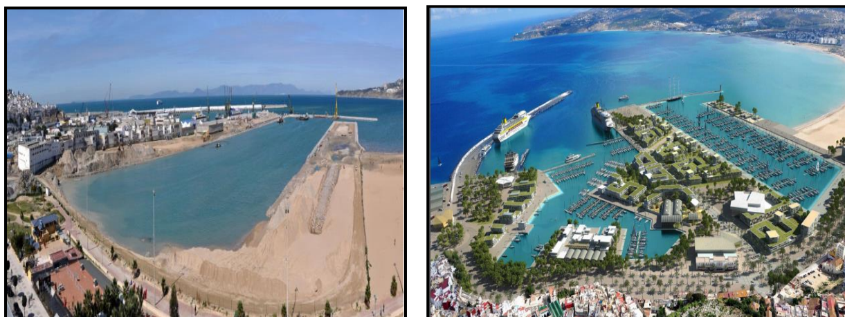
Figure 3 : Vue générale sur le port de Tanger avant et après la reconversion.
