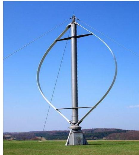
Figure I.4b- rotor de Darrieus
