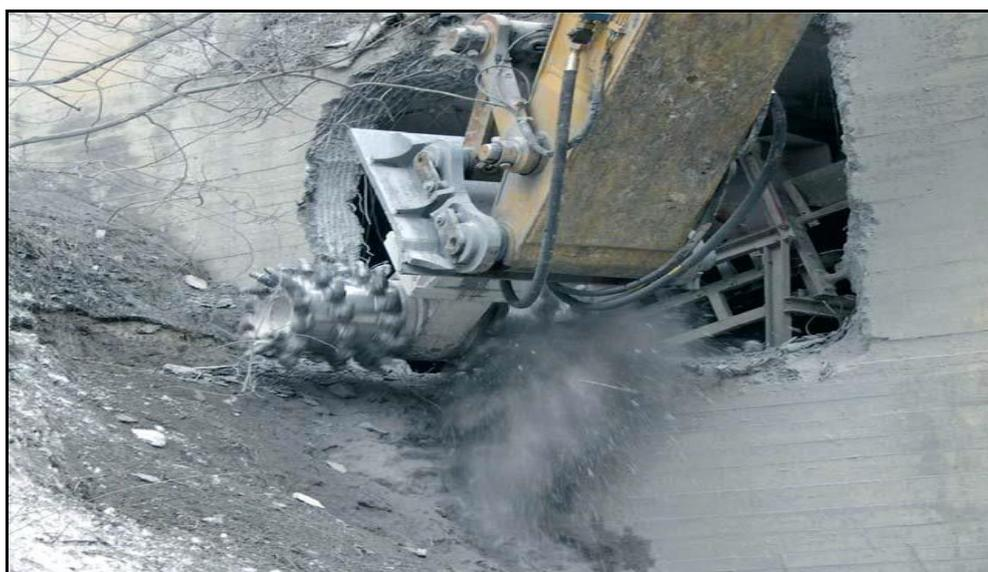
**Figure 01.** Haveuse de finition SANDVIK MA 720
